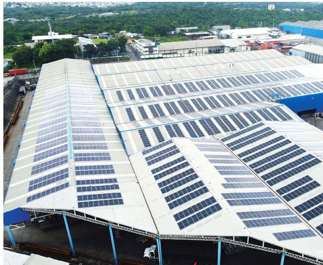
伊帕克光伏项目
