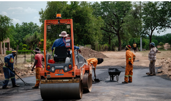
河钢南非矿业在当地社区建设公路
